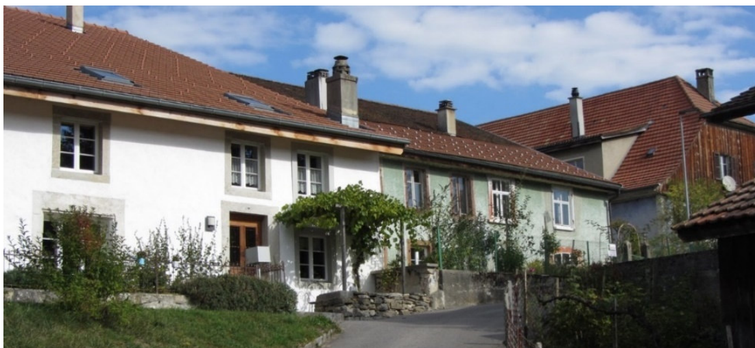
iii. IXX.30 : Pontenet - Clos des Arbres
